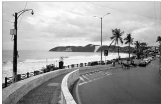
Com a obra da engorda, problemas com a erosão no Morro serão solucionados
